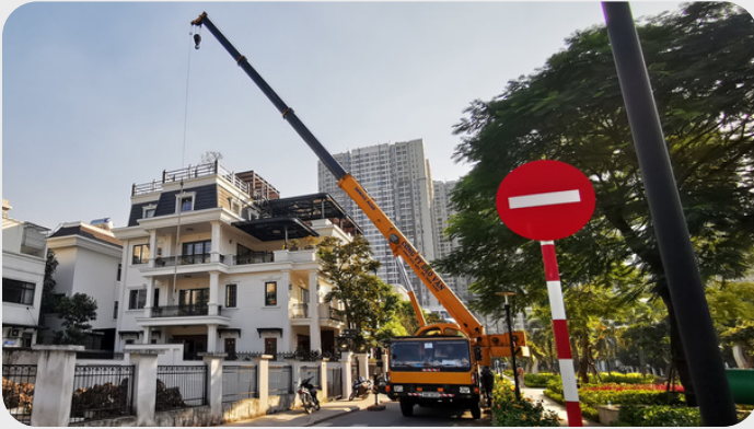
1 Xe cầu hỗ trợ nâng hạ, tháo dỡ, lắp đặt công trình
