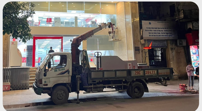
6 Xe cầu hỗ trợ nâng người thi công trên cao
