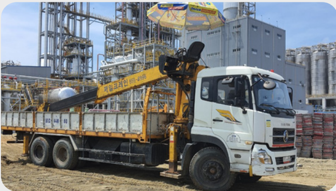
3 Xe cầu hỗ trợ di dời, dọn nhà xưởng, kho bãi
